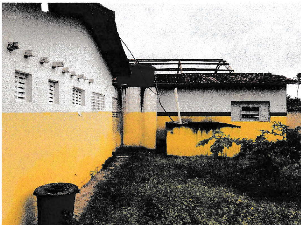
Foto 2 – A parte posterior da escola será pavimentadas com blocos intertravados e a parede da cozinha será demolida para que se faça a ampliação da mesma em direção aos fundos, conforme projeto.
