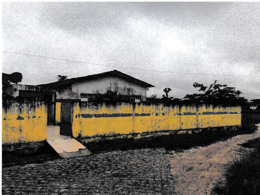
Foto 4 – A fachada da escola será revitalizada, com muros sendo reparados e repintados. A calçada será feita de concreto e a rampa de acessibilidade será demolida e refeita.
