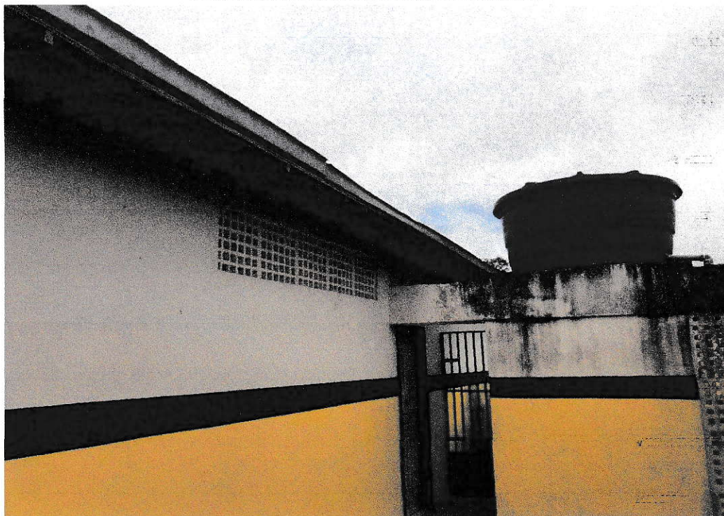
Foto 1 – Parte final do pátio central: Será construído um abrigo para a caixa d'água, deixando a o reservatório confinado.
