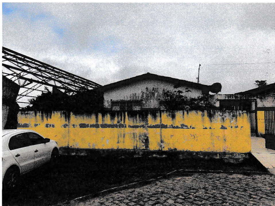
Foto 5 – O muro da fachada será totalmente reparado. A calçada que hoje é de terra será concretada por inteiro facilitando o trânsito dos alunos. O portão principal será retirado e colocado um portão maior.
