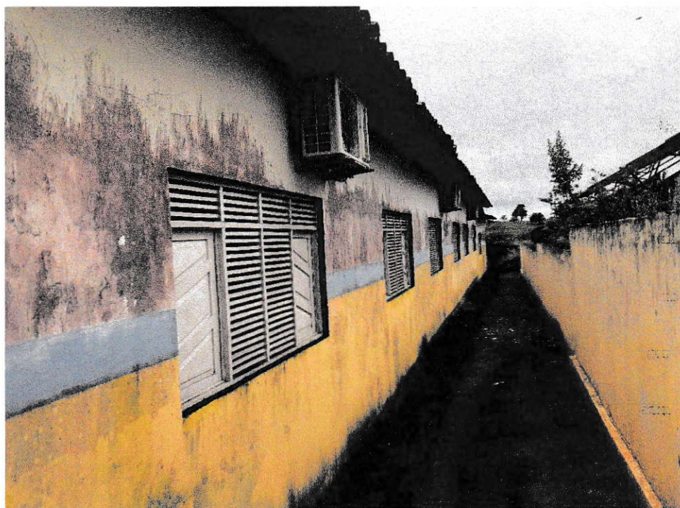
Foto 7 – Fachada lateral direita da escola. Será pavimentada toda a área com blocos intertravados. As paredes serão repintadas e as esquadrias substituídas. Os muros também serão reparados.
