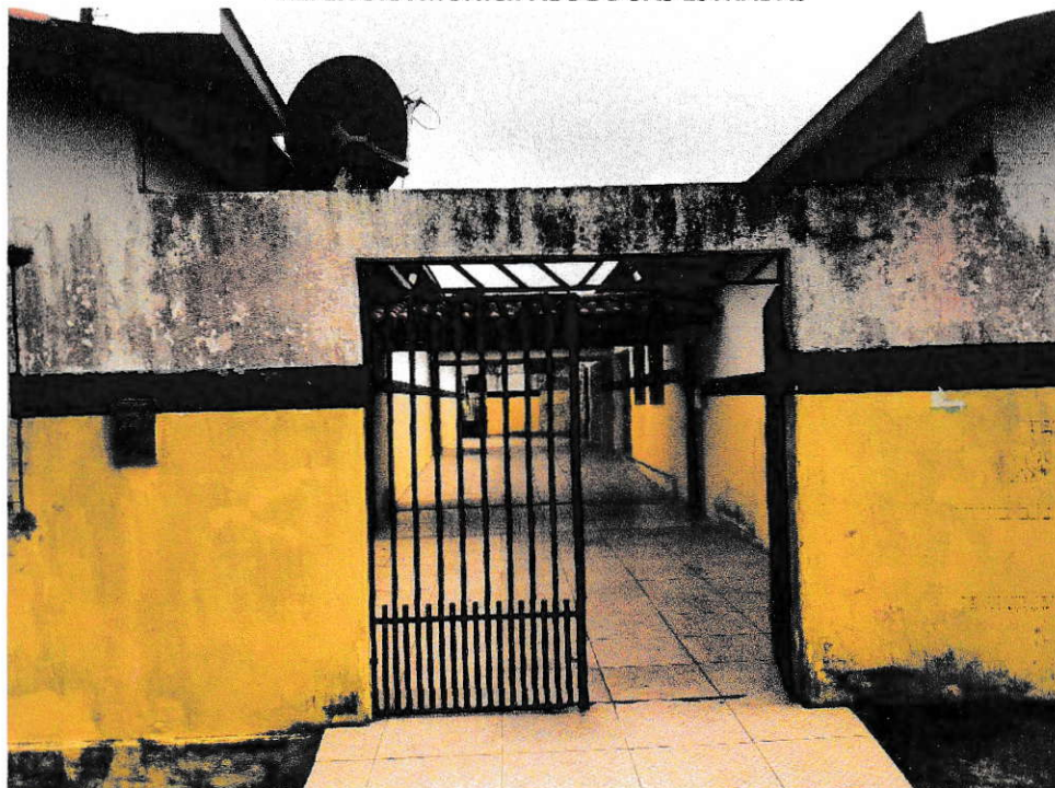
Foto 6 - O portão secundária será mantido e os beirais serão retirados para a construção da platibanda com 1,20 m de altura. Será construída uma laje cobrindo toda a passarela até o muro frontal.
